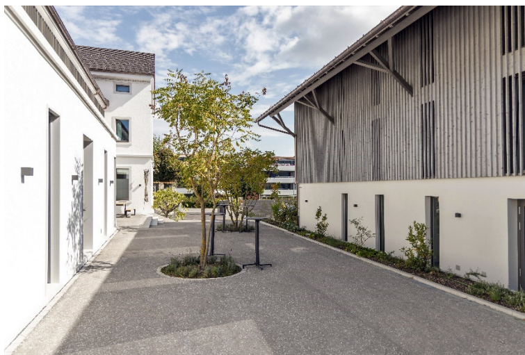
Abbildung 17: Referenzbild mit offenen Baumruben und Farbasphaltflächen, Quelle SKK
