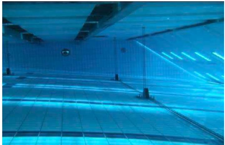
Abbildung: Bsp. Seilzugsystem unter Hubbodenabdeckung
