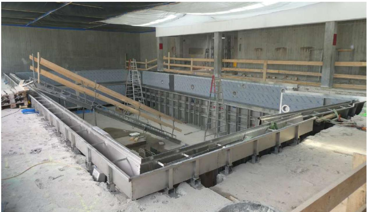
Die Edelstahl-Beckenwand wird mit einer selbsttragenden Unterkonstruktion aus Edelstahl ins bestehende Becken versetzt.
