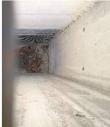
Abbildung 20: Aussenluftansaugung in Lichtschacht
