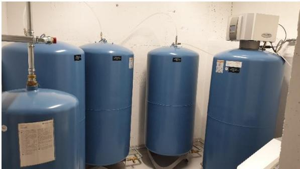
Abbildung 32: Expansionsanlage
